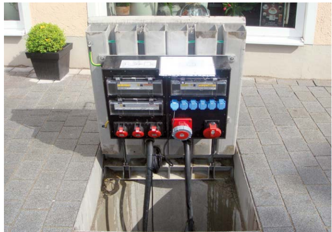
Fischbrunnensquare in Eggenfelden
