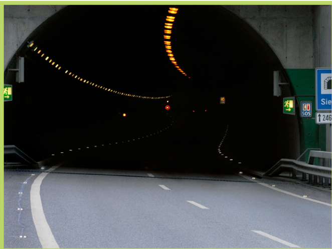
Tunnel St. Maurice, Valais
