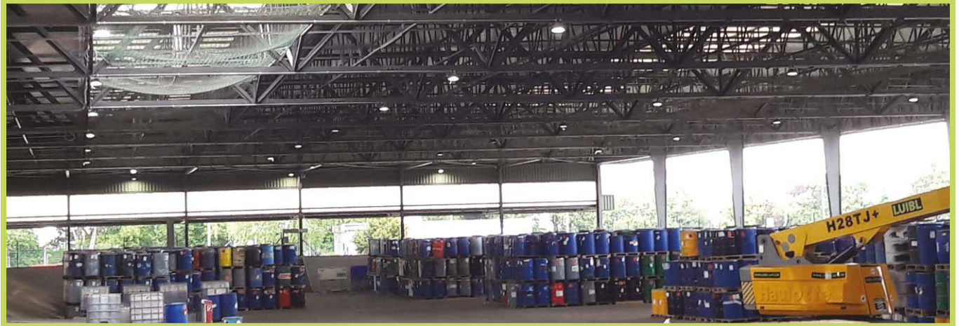
DeltaLUXX - Osvetlenie skladovacích priestorov
