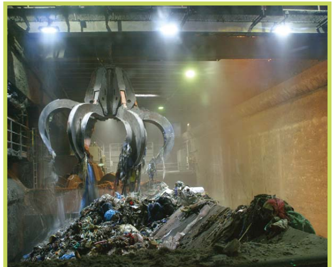
PLAZA - Osvetlenie v spaľovni odpadu
