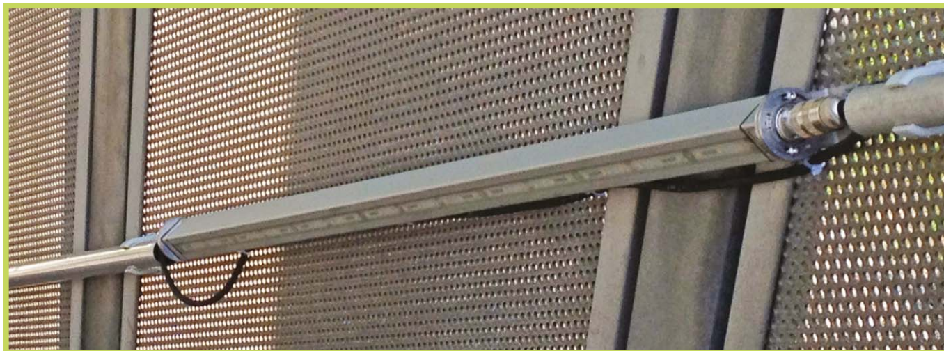
AmbitLED Power- Osvetlenie nadchodu na zábradlí
