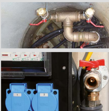
Prípojka vody v / na šachte alebo prípojka vody na kryte šachty.
