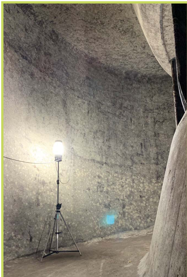
ApolloLED ECO – Osvetlenie počas revízných prác v elektrárni
